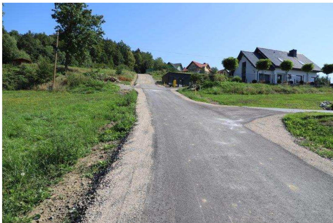
Przebudowa drogi rolniczej w Kłodnem
