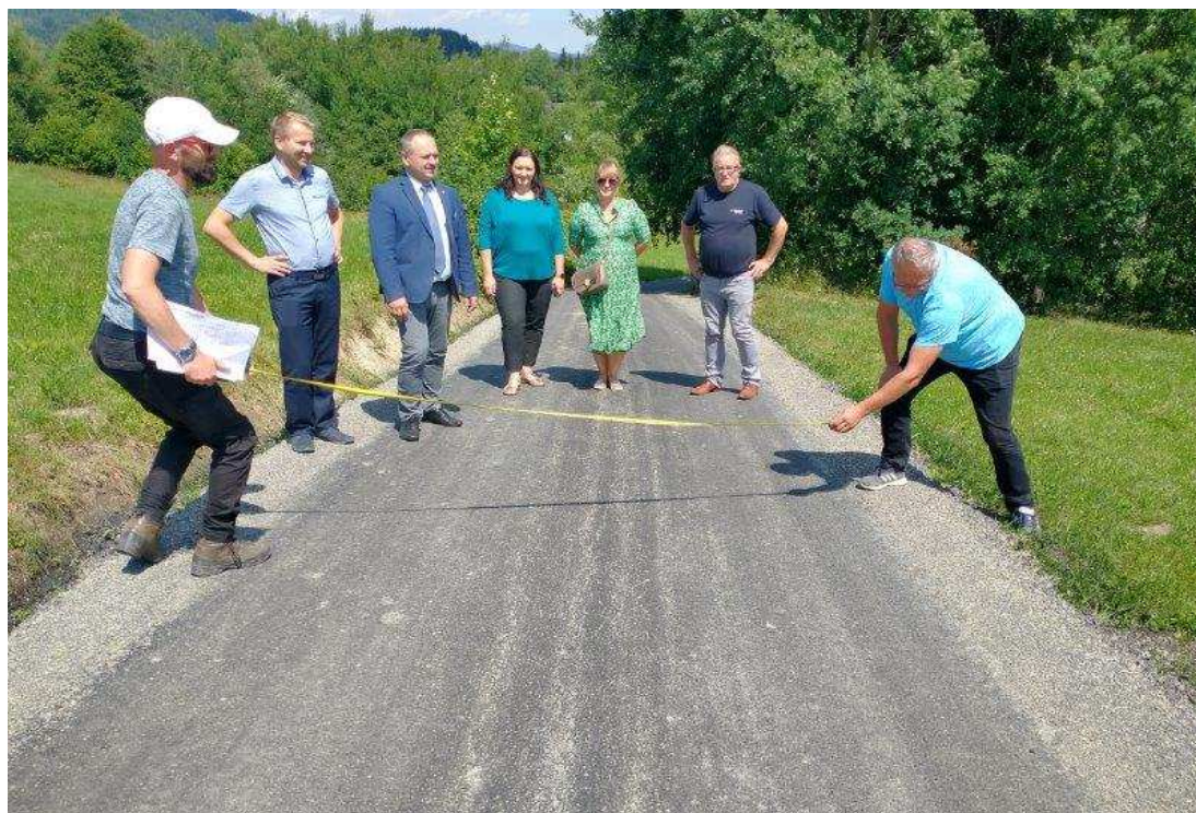
Remont drogi gminnej Stara Wieś-Podlas-Golców
