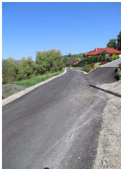
Budowa drogi gminnej w Kłodnem
