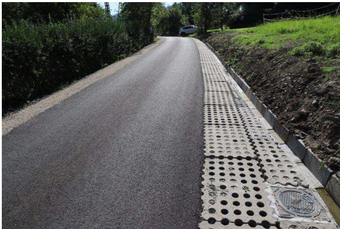
Budowa drogi gminnej w Sowlinach
