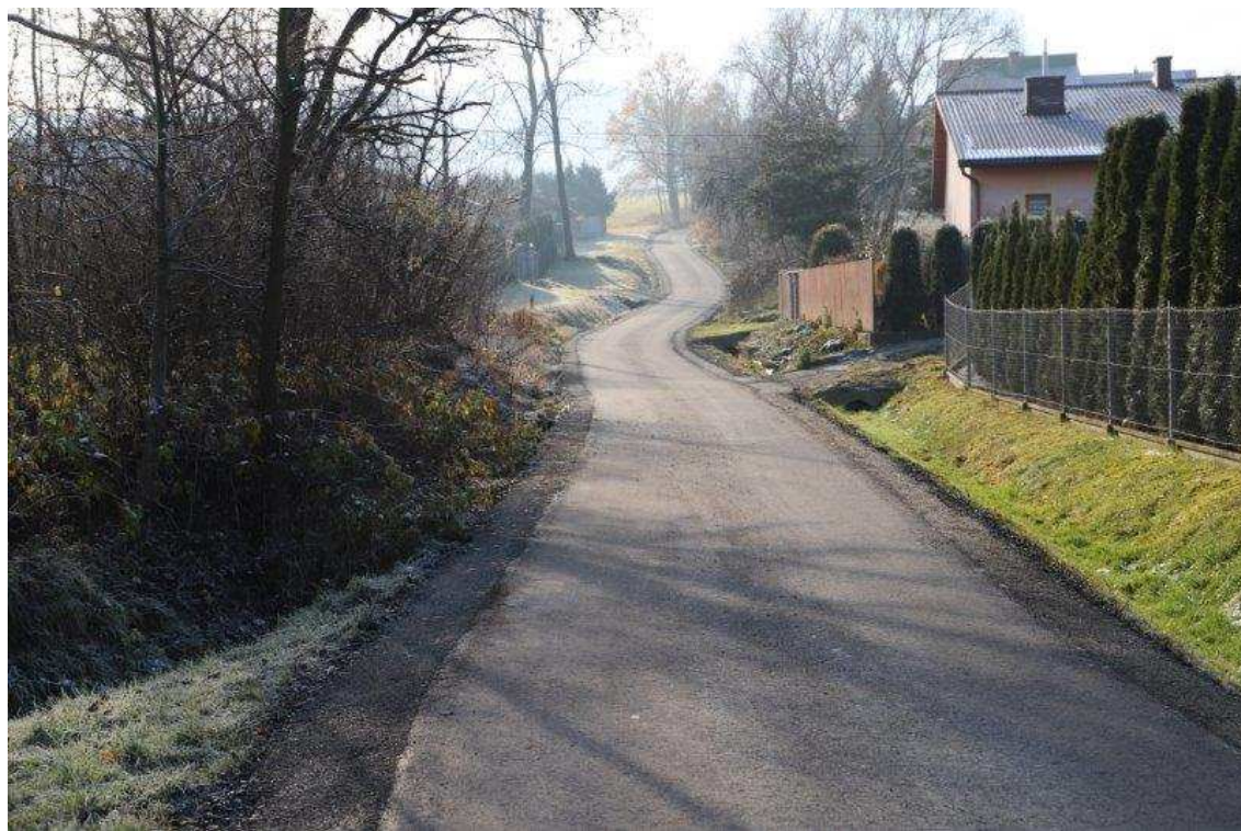
Remont drogi Męcina-Zakrętek
