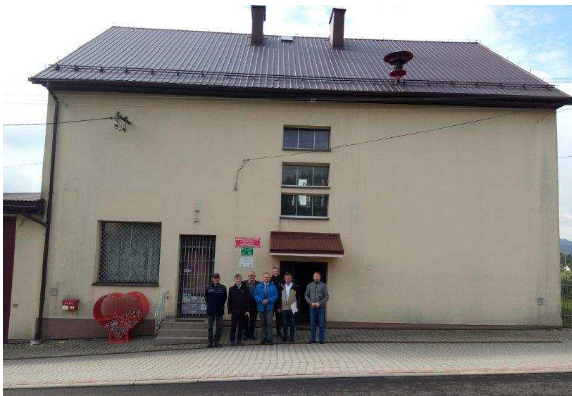
Remont dachu - OSP Rupniów
