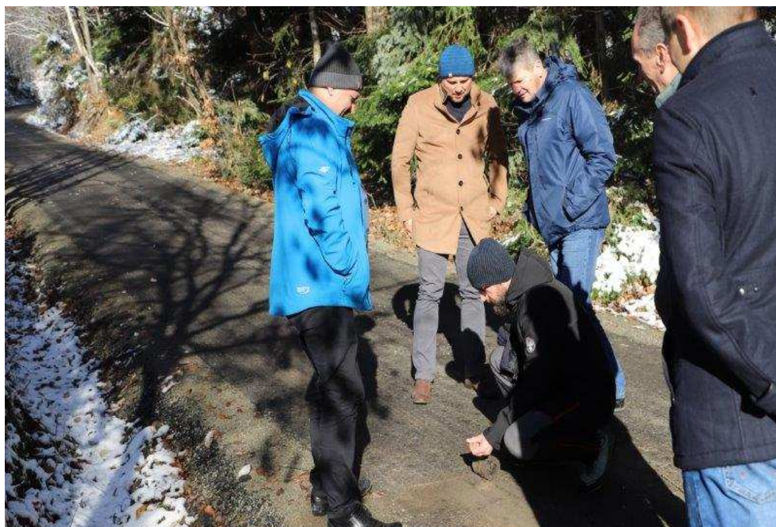
Budowa drogi gminnej Pisarzowa-Meksyk
