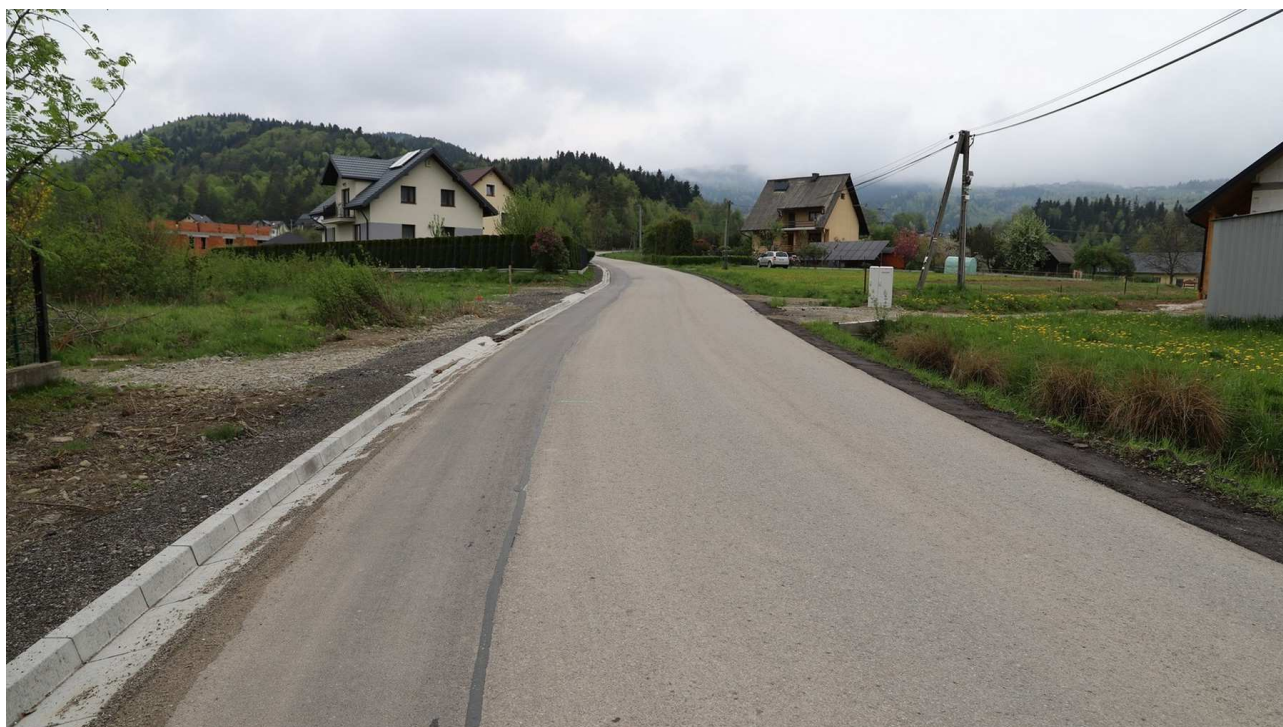
Modernizacja drogi Męcina - Miczaki
