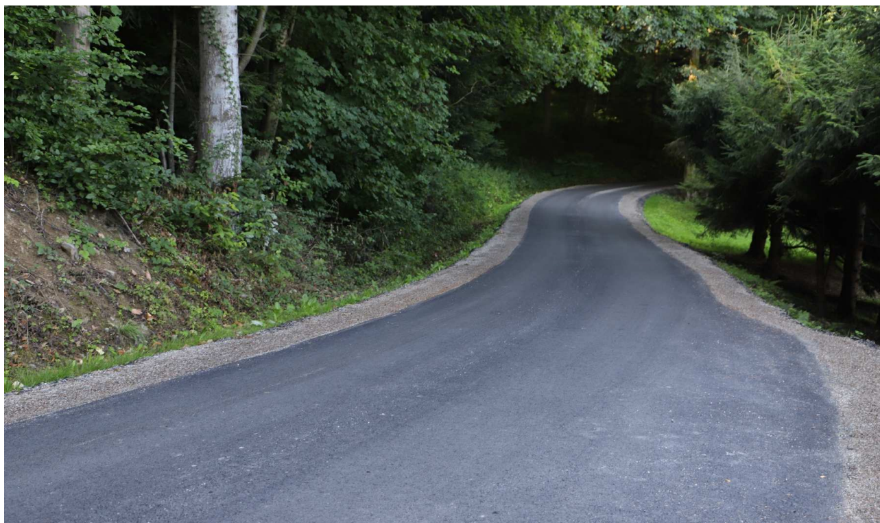
Modernizacja drogi w Łososinie Górnej
