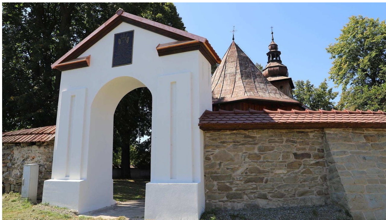
Remont zabytkowego muru przy kościele parafialnej w Męcinie
