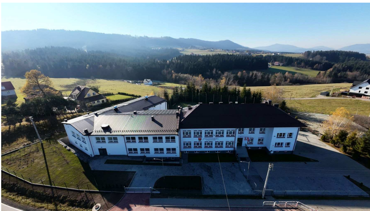
Rozbudowa Szkoła Podstawowej Nr 2 w Siekierczynie
