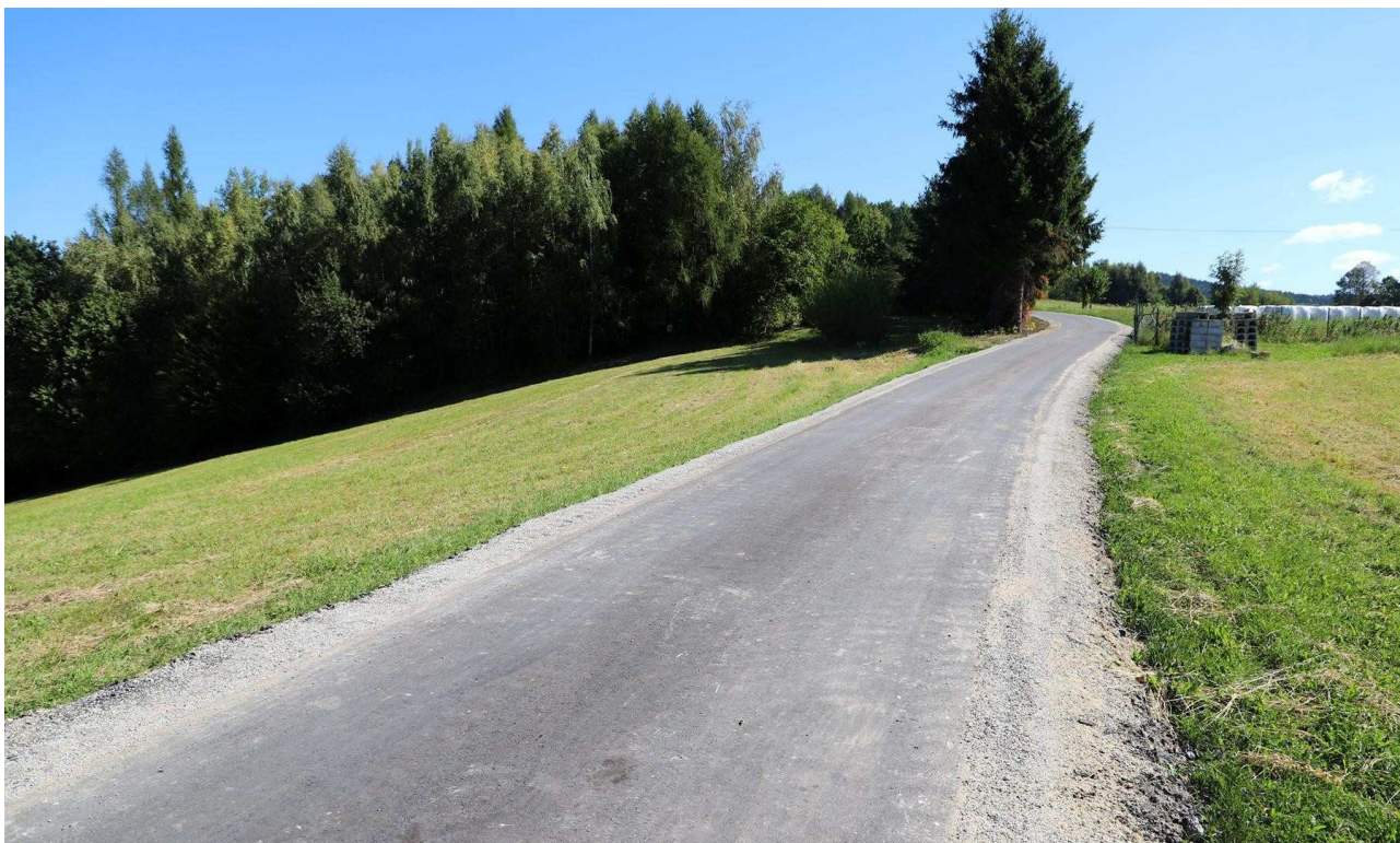
Modernizacja drogi w Pisarzowej
