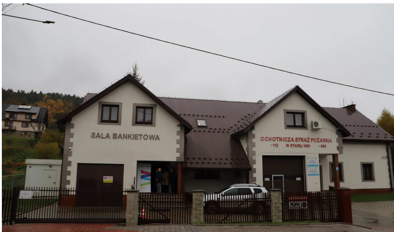
Modernizacja budynku OSP w Starej Wsi
