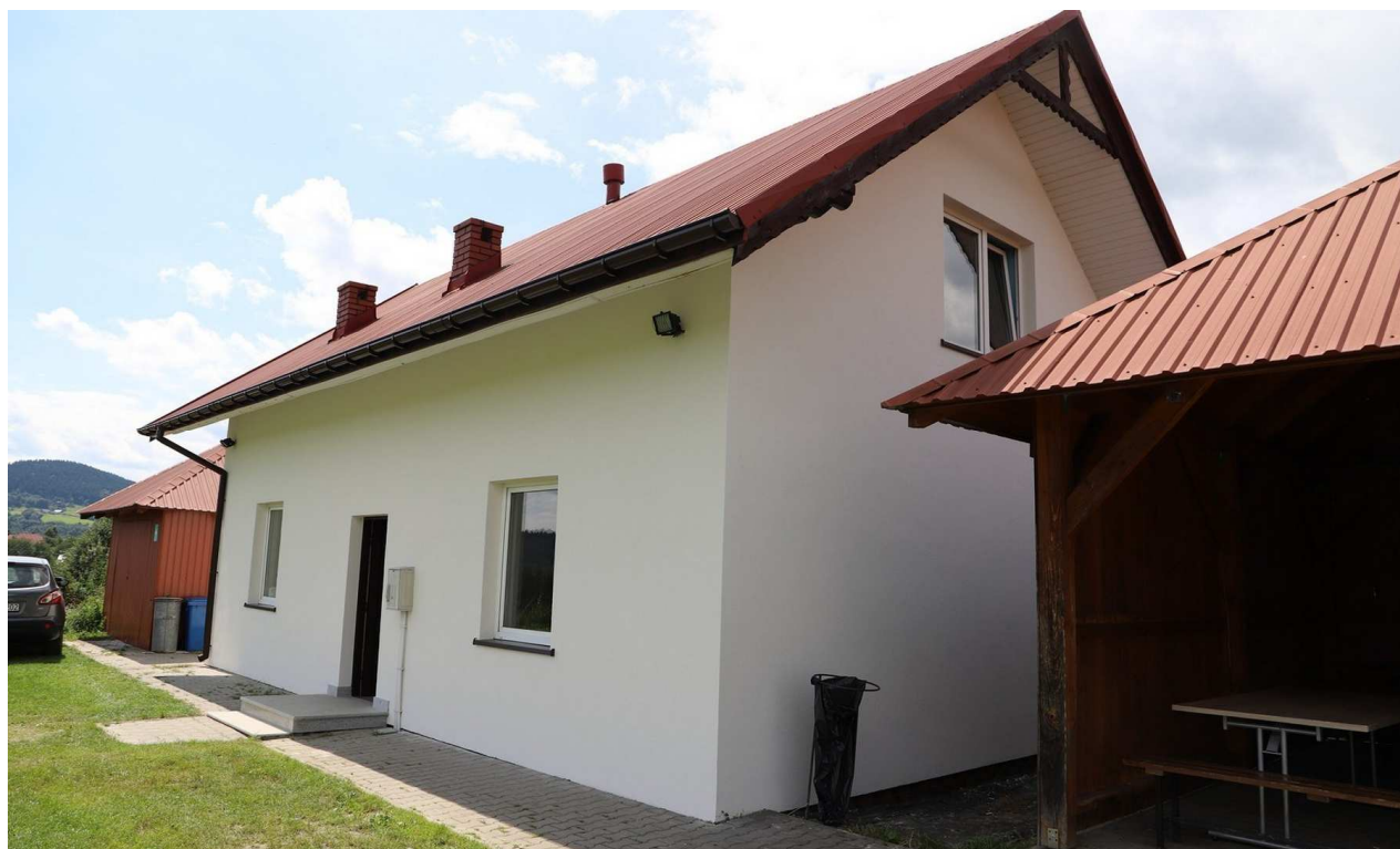
Remont budynku zaplecza sportowego w Rupniowie
