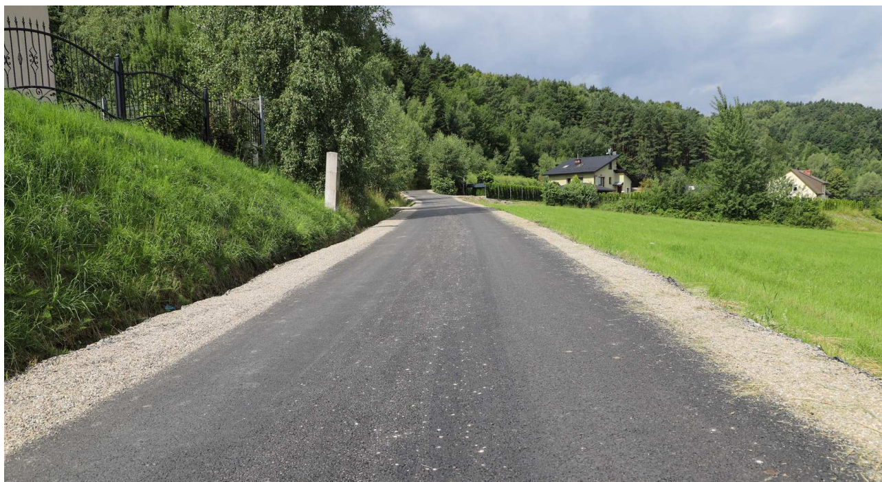
Modernizacja drogi w Siekierczynie
