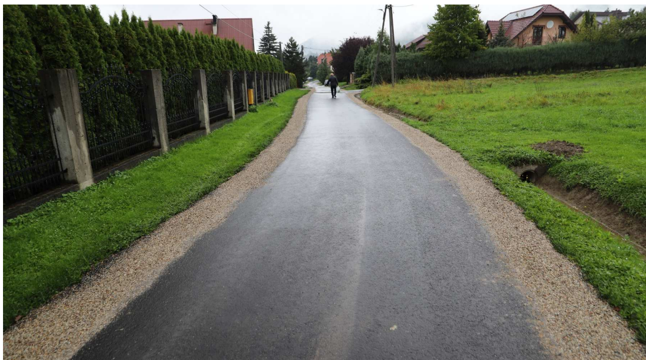
Modernizacja drogi w Rupniowie
