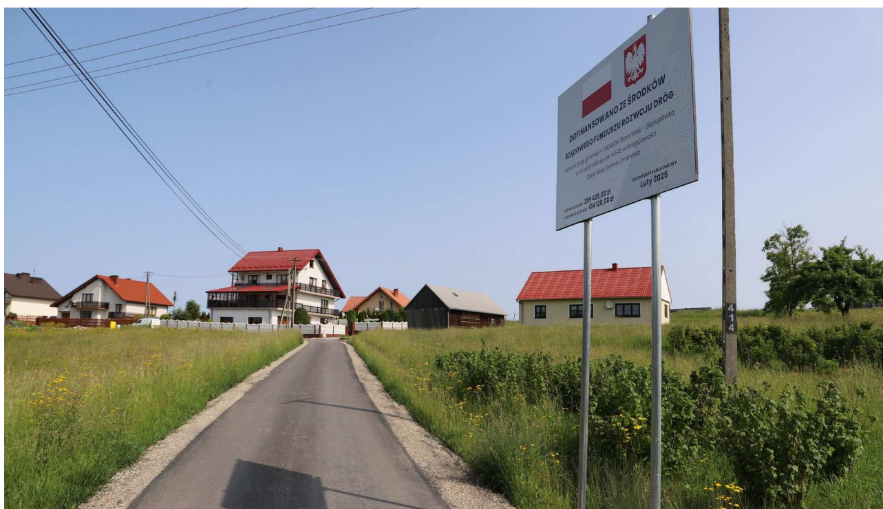
Modernizacja drogi Stara Wieś - Skorupówka
