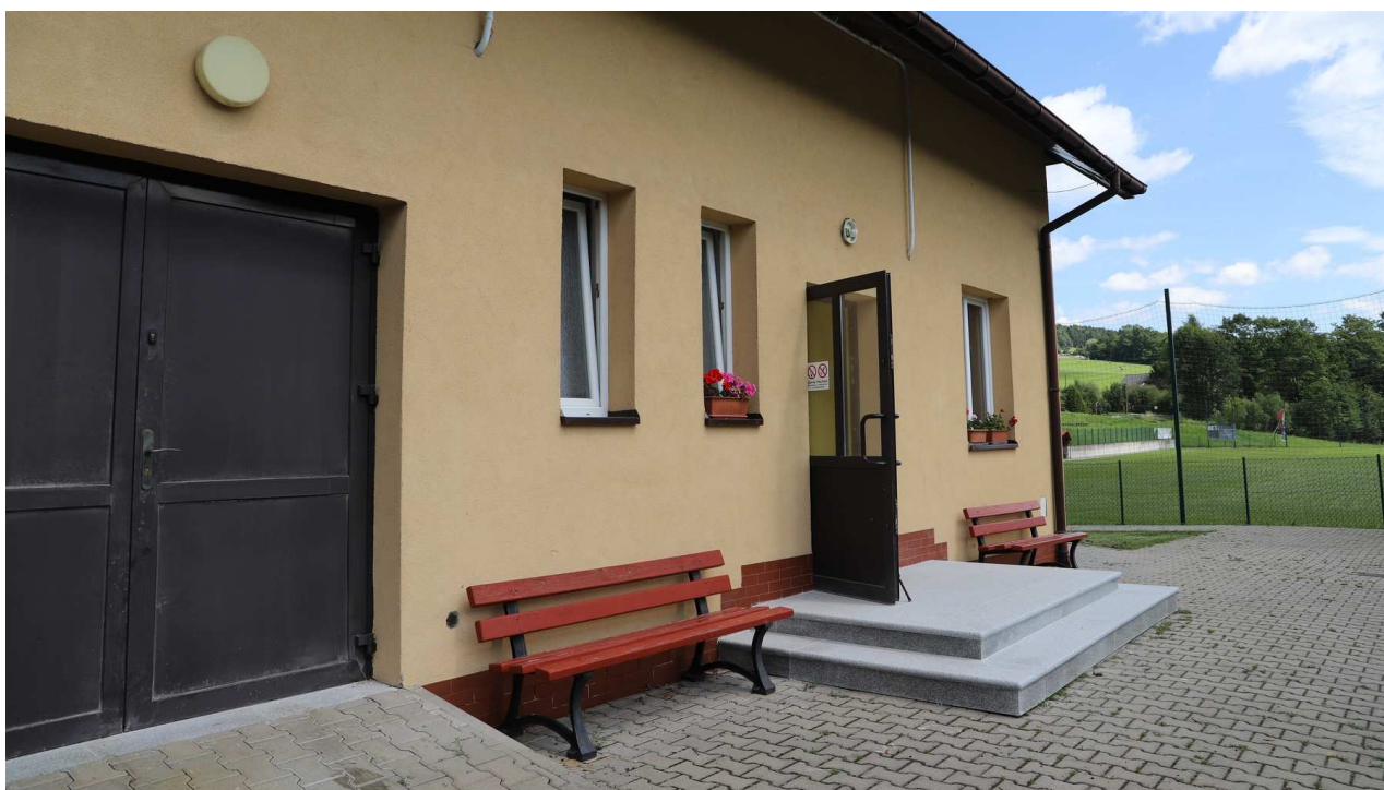
Remont budynku zaplecza sportowego w Siekierczynie
