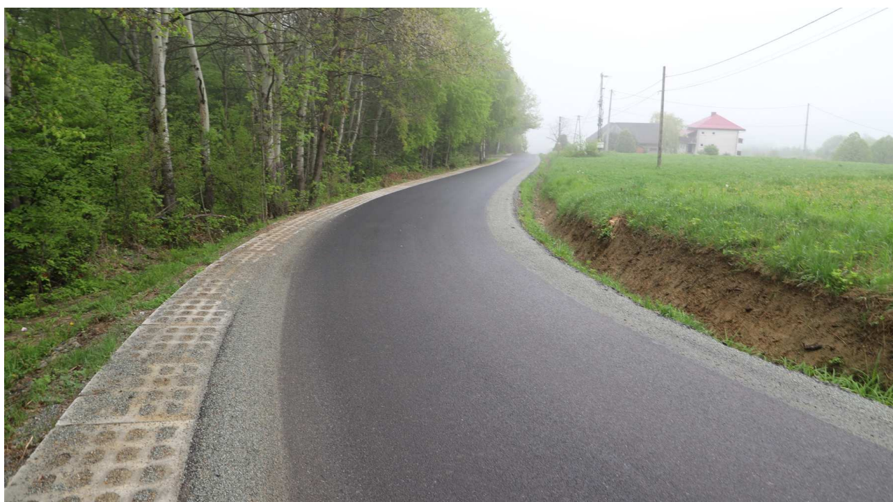
Modernizacja drogi Nowe Rybie - Kamionna
