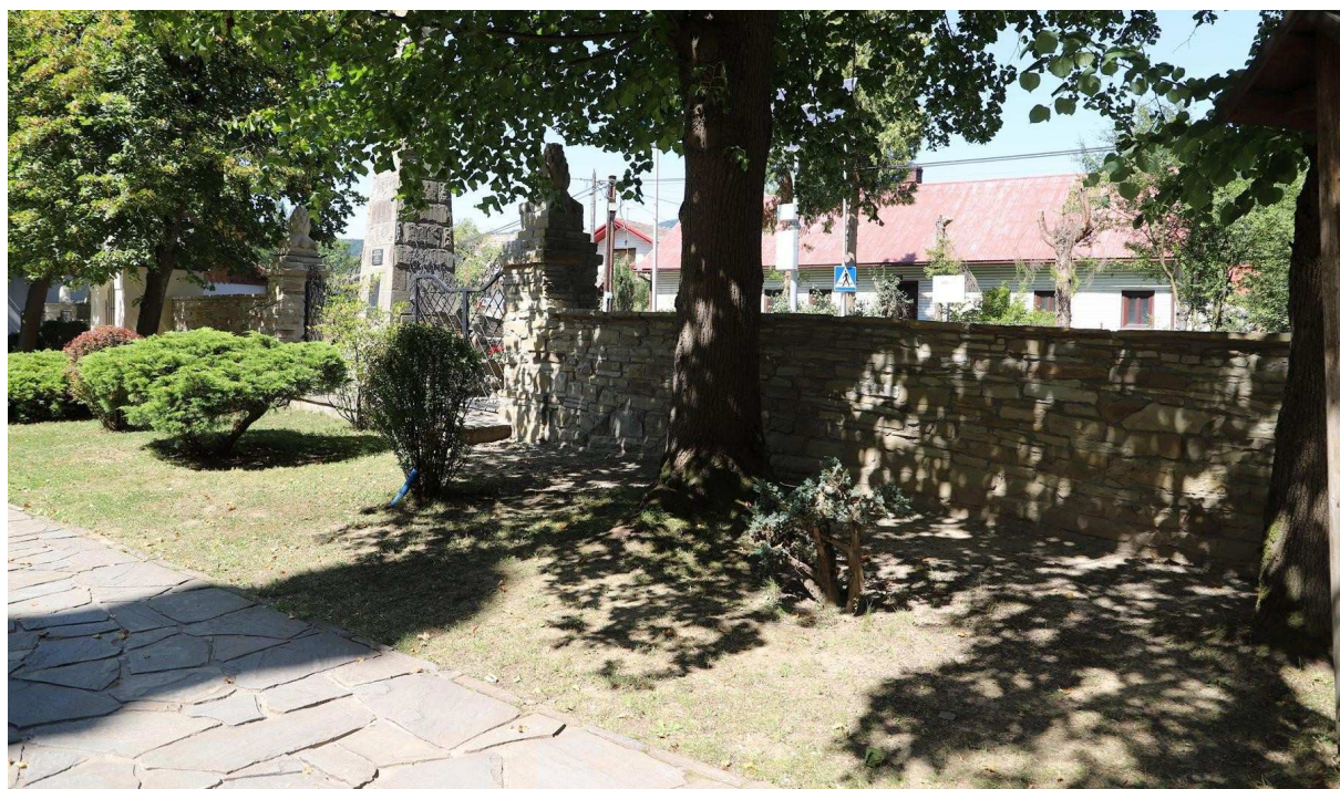
Wyremontowany mur przy kościele parafialnym w Pisarzowej
