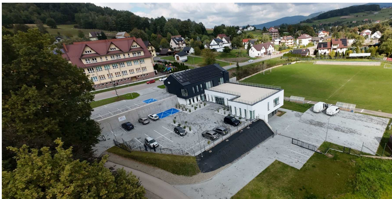
Budowa budynku wielofunkcyjnego w Starej Wsi I (przedszkole, żłobek, zaplecze sportowe)
