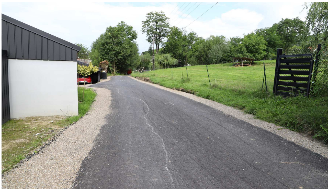
Modernizacja drogi Sowliny - Rola - Wýgon
