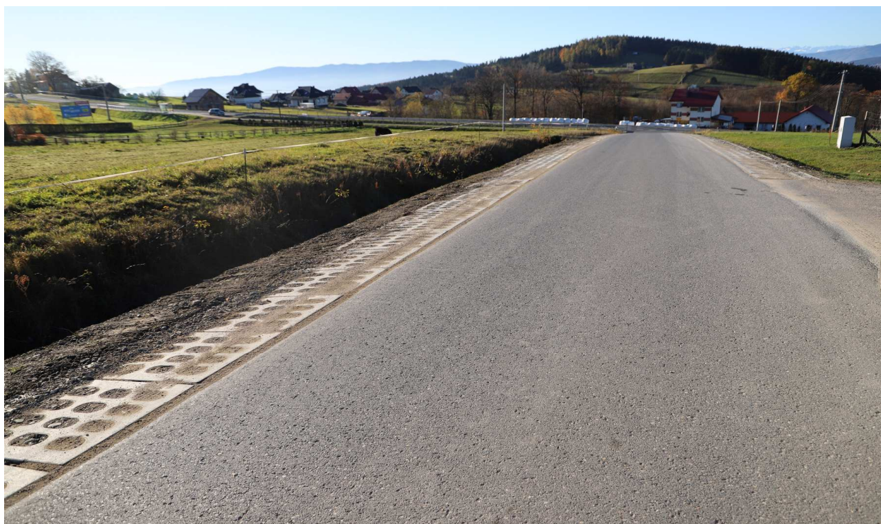
Modernizacja drogi Męcina - Wysokie
