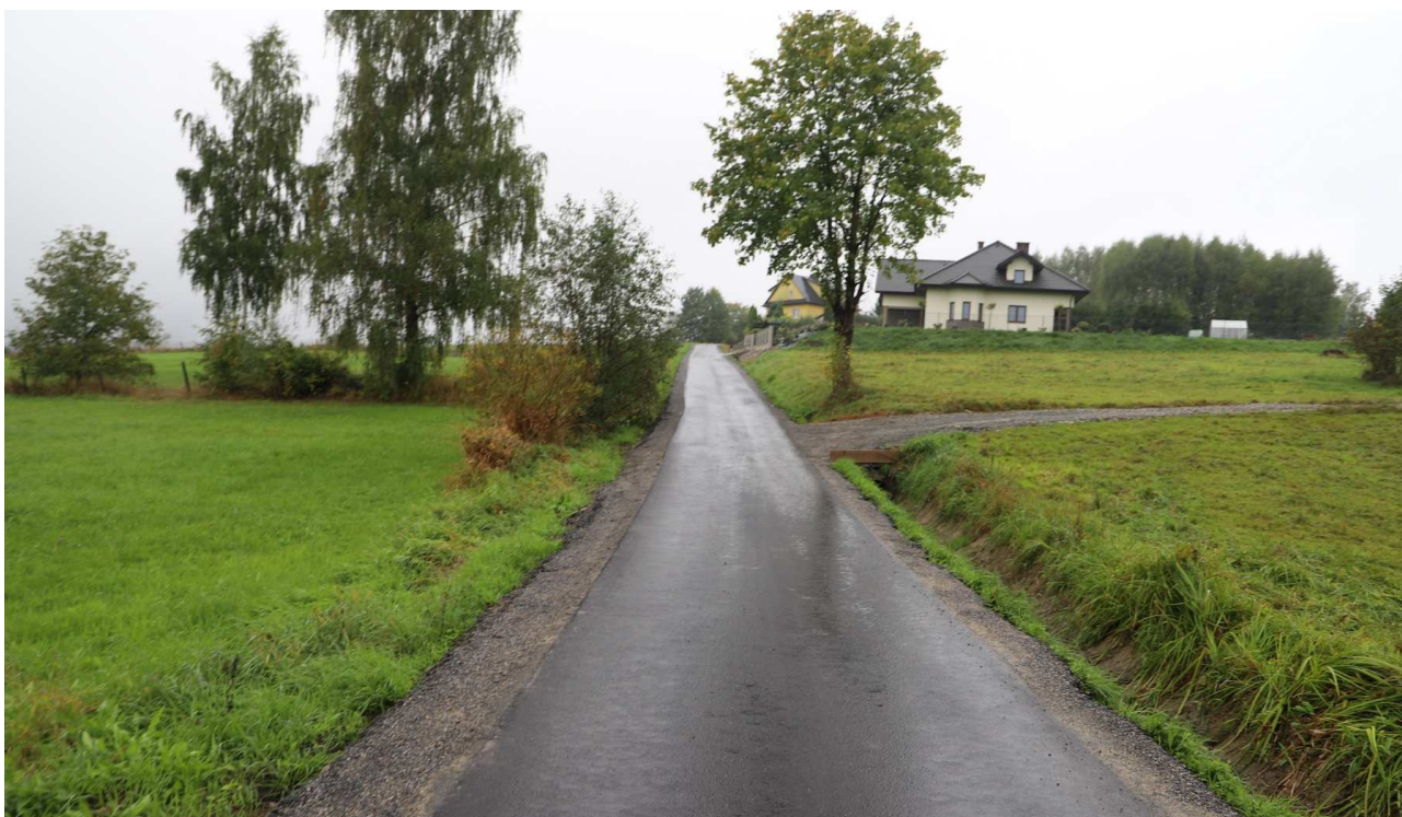
Modernizacja drogi w Rupniowie
