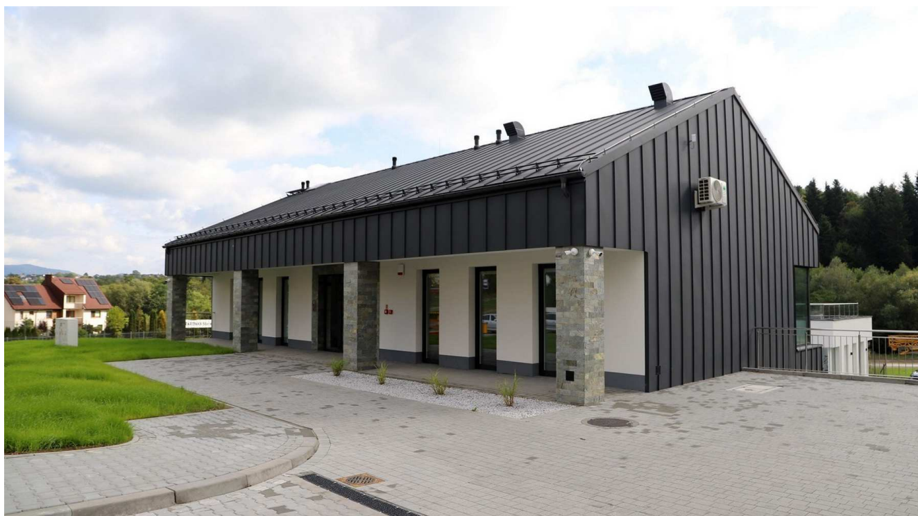
Budowa budynku wielofunkcyjnego w Starej Wsi I (przedszkole, żłobek, zaplecze sportowe)
