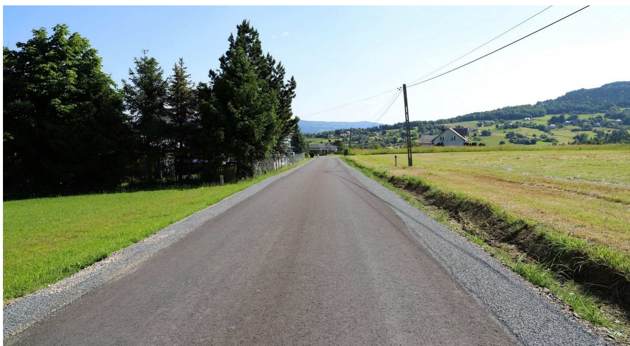
Modernizacja drogi Stara Wieś - Zakopane
