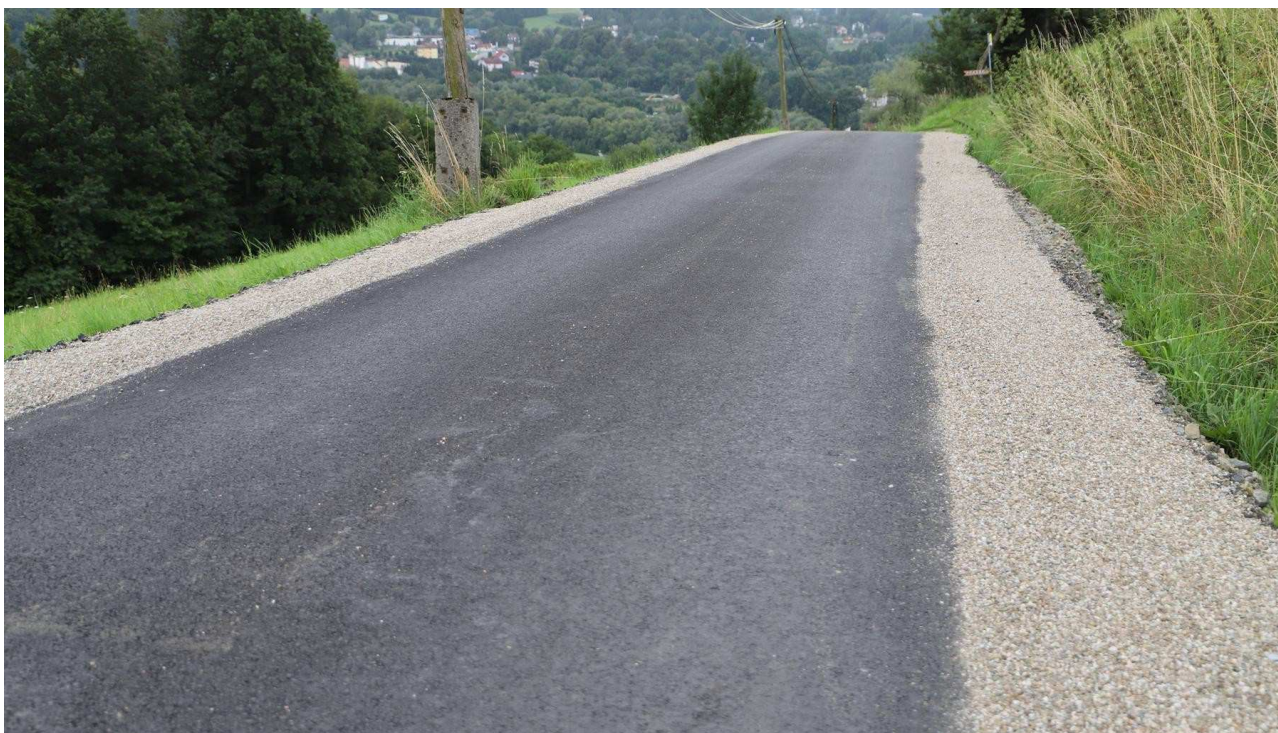
Modernizacja drogi w Siekierczynie
