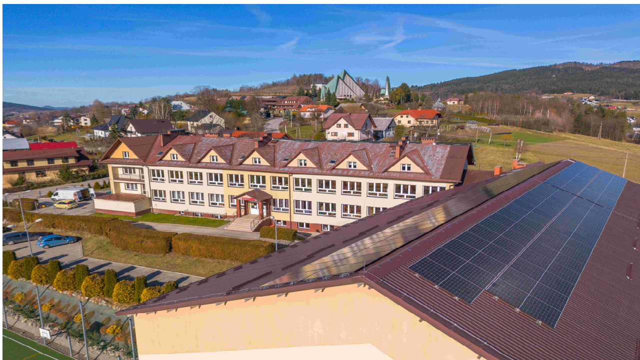
Termomodernizacja obiektów oświatowych - Szkoła Podstawowa w Pasierbcu
