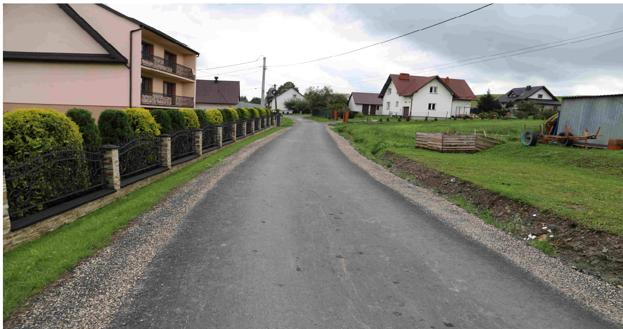
Droga gminna Siekierzyna - obwodnica
