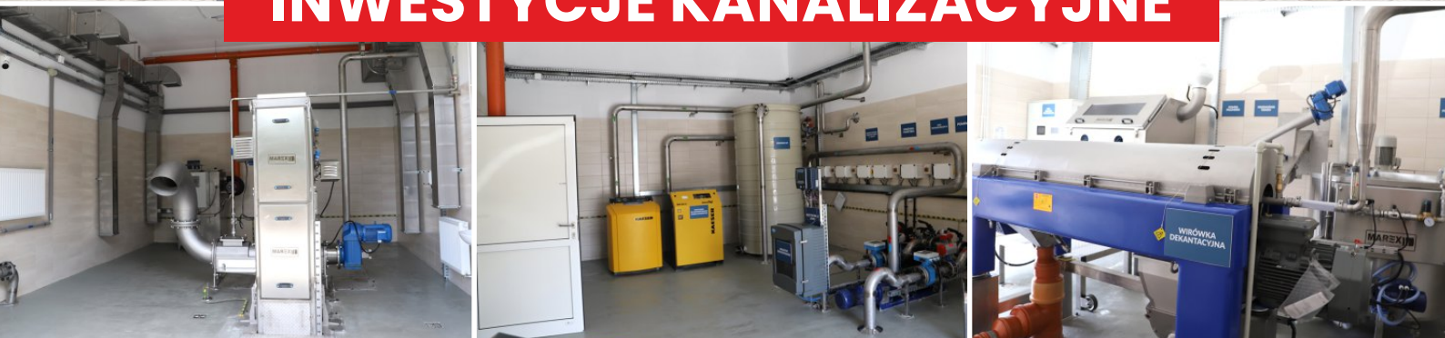
Oczyszczalnia ścieków w Starej Wsi
