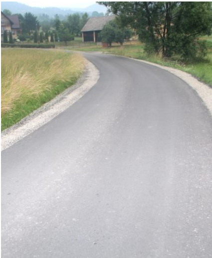
Droga Męcina - Podgórze
