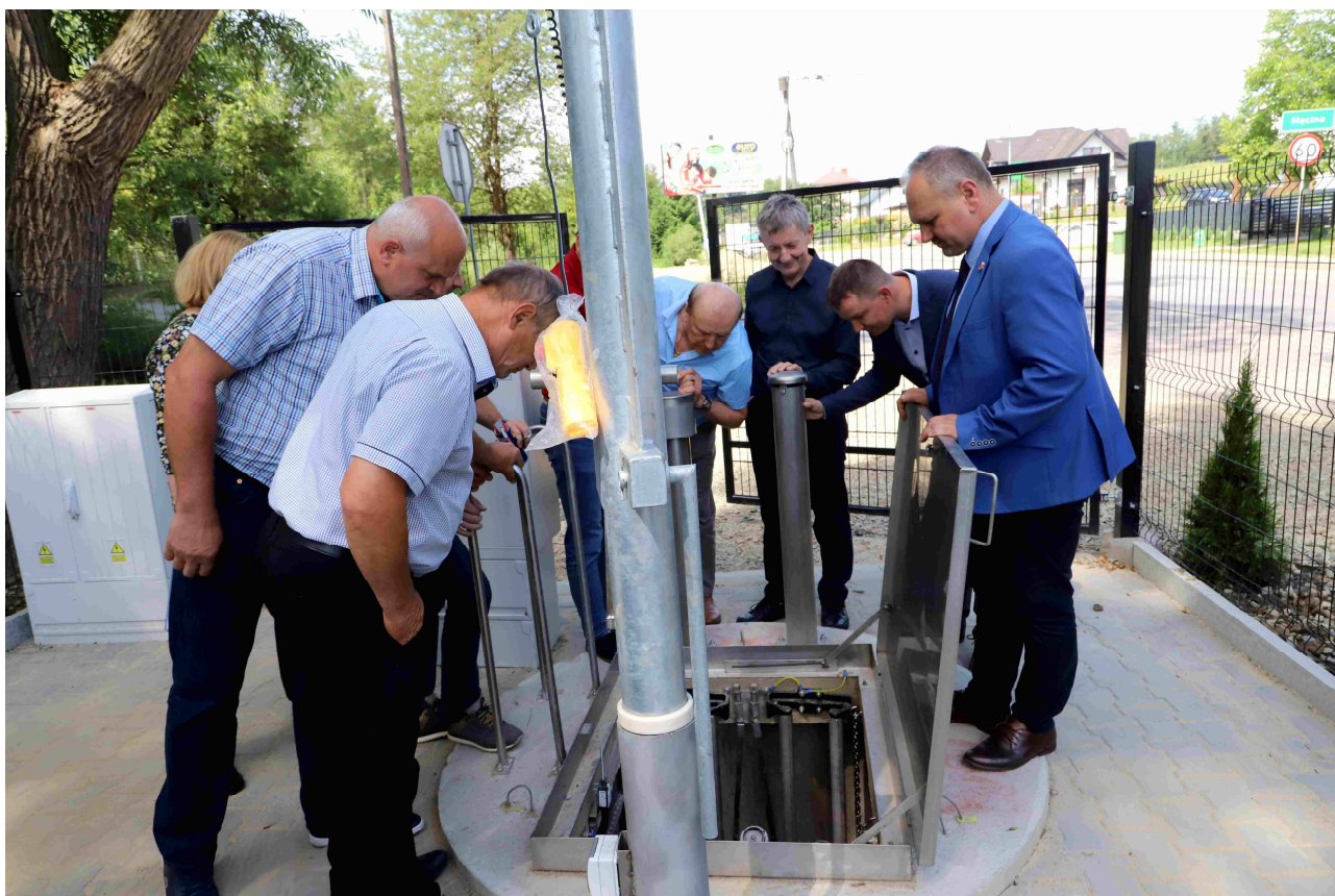
Budowa sieci kanalizacji sanitarnej i wodociągowej w miejscowości Kłodne i Męcina
