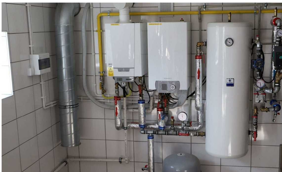
Modernizacja kotłowni w Szkole Podstawowej w Starym Rybiu
