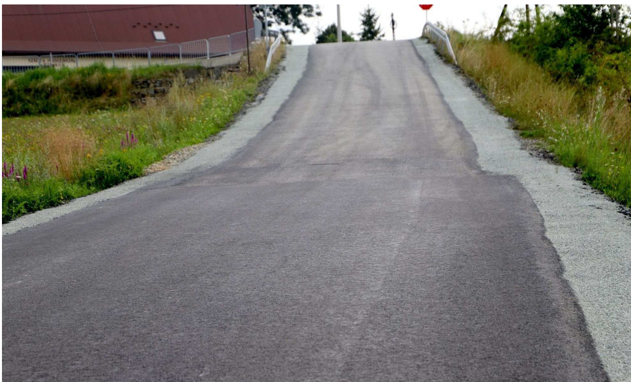
Droga Wysokie - Przyszowa
