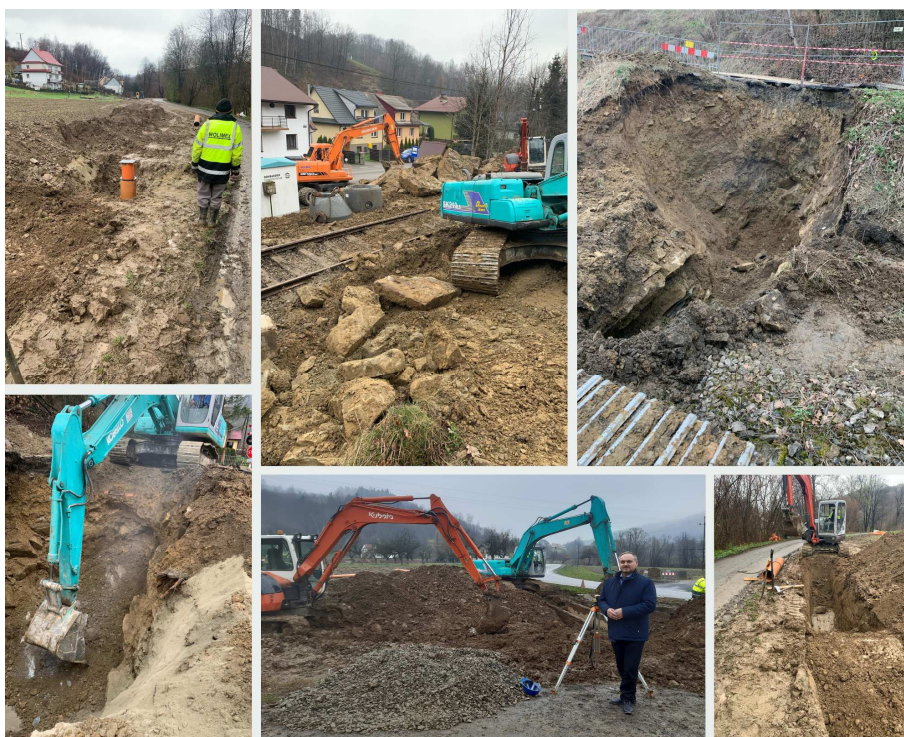
Budowa sieci kanalizacji sanitarnej zachodniej części Gminy Limanowa
