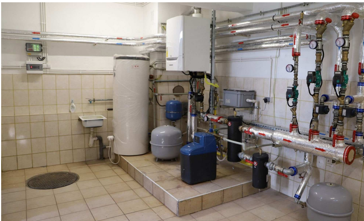
Modernizacja kotłowni w Szkole Podstawowej nr 2 w Męcinie
