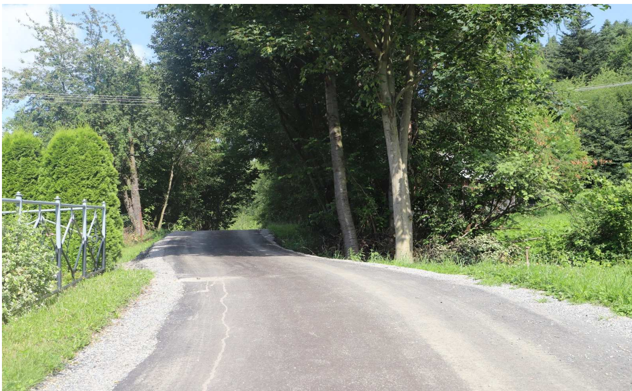
Modernizacja dróg – Młynne Padoły
