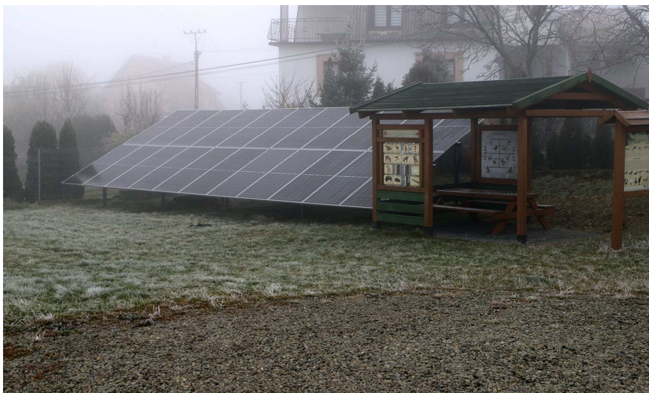
Modernizacja kotłowni z zastosowaniem odnawialnych źródeł energii w budynku OSP Wysokie
