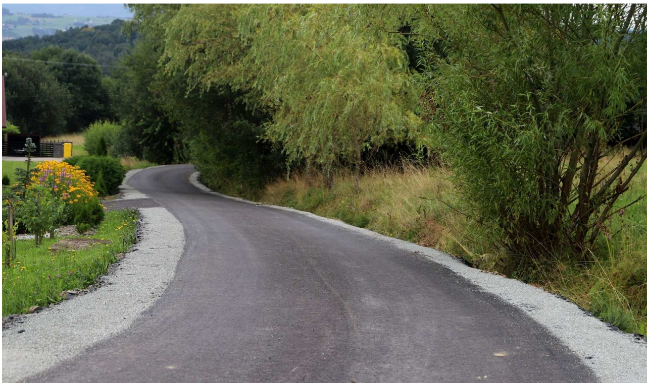
Modernizacja dróg – Makowica nad świetlicą
