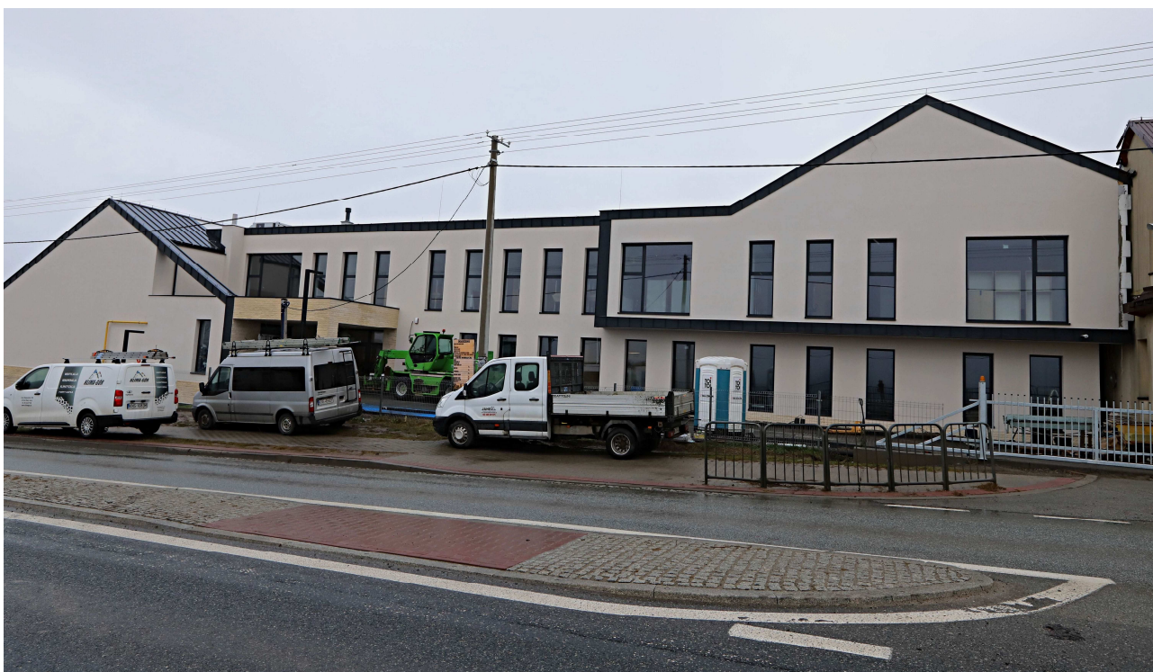
Budowa Szkoły Podstawowej wraz z sala gimnastyczną w Wysokiem
