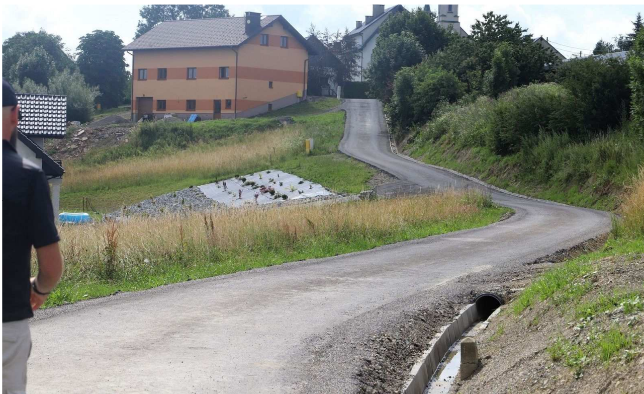
Modernizacja dróg – Kanina k. Stolarni
